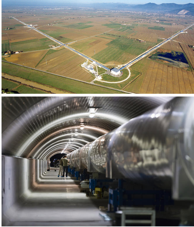
FIGURE 41 – Observatoire des ondes gravitationnelles Virgo. En haut : vu du ciel, montrant les deux bras, chacun mesurant 3 km de long et perpendiculaires l'un à l'autre. En bas : à l'intérieur du tunnel ouest. Chaque tunnel contient un tube dans lequel les faisceaux laser voyagent sous ultra-vide. Image : EGO/Virgo. CC BY SA
