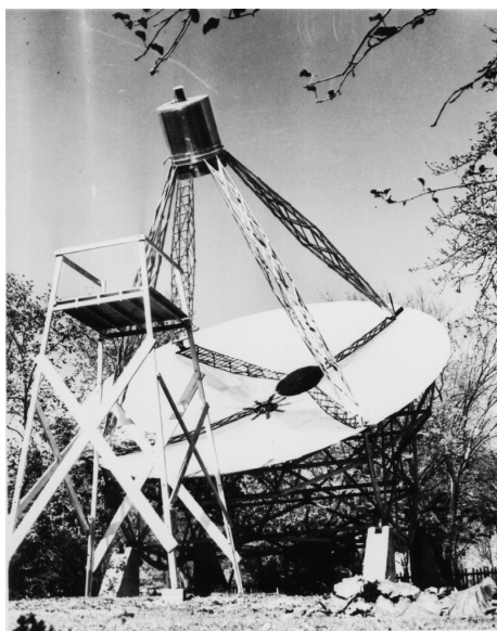
FIGURE 12 – L'un des tout premiers détecteurs radio spécialement conçus pour observer les sources célestes. Il est devenu opérationnel en septembre 1937. Image : Grote Reber. Domaine public
